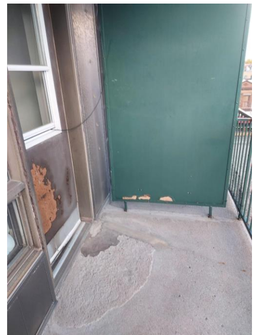
Photo 1 : Le sol du balcon n'est pas au niveau donc on ne peut pas s'y assoir.
